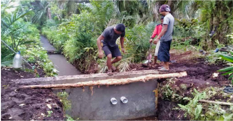
Gambar 4.17 Sekat kanal dengan satu lapisan dinding beton yang disepakati bersama anggota masyarakat dengan tipe yang berkualitas tinggi (permanen).
