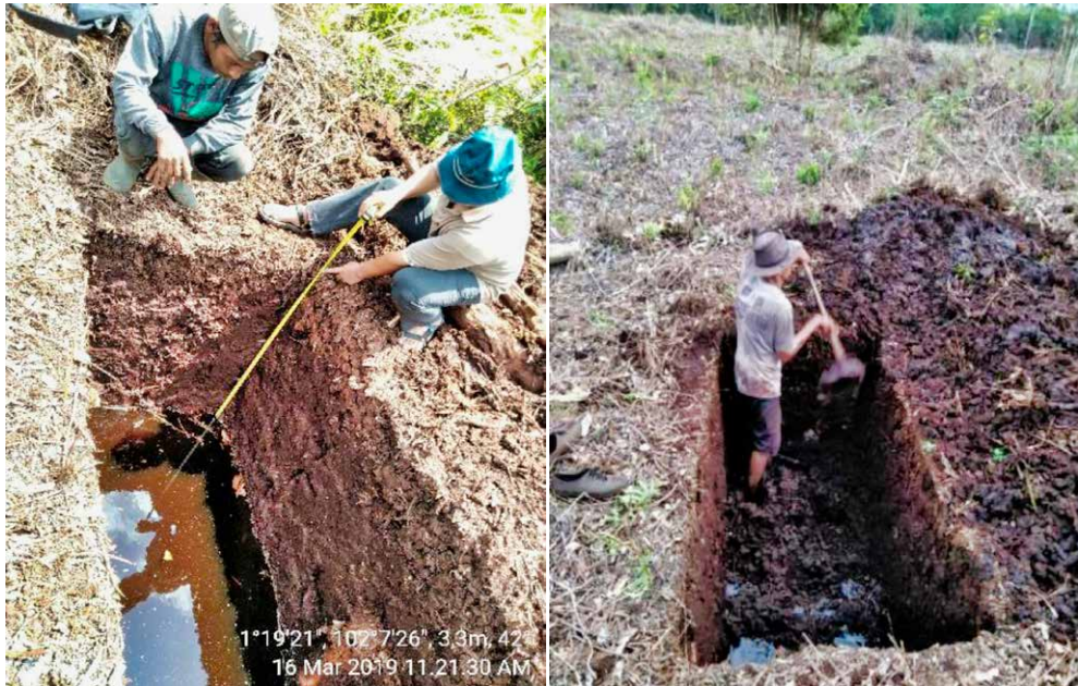
Gambar 5.8 Penggalian perigi secara manual menggunakan cangkul dan pemanfaatannya untuk pemantauan kedalaman muka air tanah di lahan gambut
